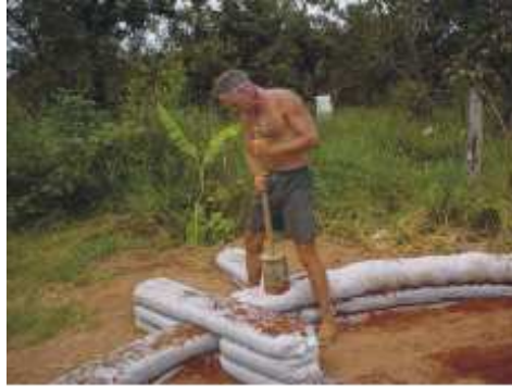
Fotos do Cal-Earth Institute em Hesperia, California, EUA onde o arquitecto Nader Khalili desenvolveu e ensina a técnica de construção com Super-Adobe.
